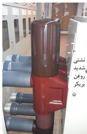
شکل ۲: قطع جریان شدید اتصال کوتاه و پاشش شدید روغن بریکر
