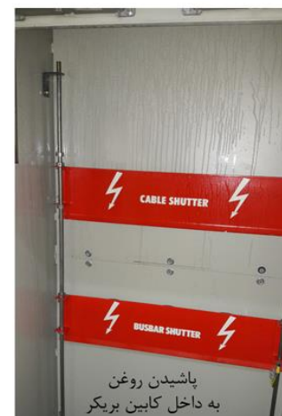
شکل ۲: قطع جریان شدید اتصال کوتاه و پاشش شدید روغن بریکر
