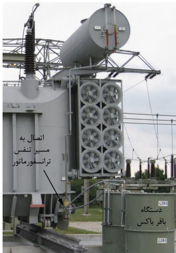
شکل ۷: اضافه کردن بافرباکس در مسیر تنفس ترانسفورماتور
